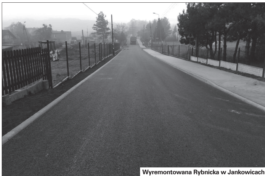
Prace na ulicy Rybnickiej w Świerklanach
